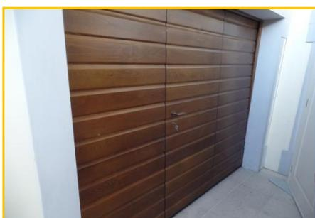
Porta basculante in legno coibentata, con porta centrale senza motore; porta sezionale color castagno e acciaio, senza motore e porta basculante in acciaio color verde con pedonale laterale.
