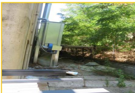
Silos esterno per aspirazione provvisto di motore e tubazione esterna.
