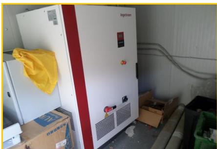
INVERT INGECON SUN 100 modello 100 kW matricola 100101060R65, inverter da 100 kW 3\*400 VAc Udc 405-900 CEI 11-20. Mai entrato in funzione; non adeguato alla CEI 0-21/ CEI 0-16.
