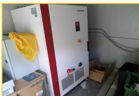
INVERT INGECON SUN 100 modello 100 kW matricola 100101060R65, inverter da 100 kW 3\*400 VAc Udc 405-900 CEI 11-20. Mai entrato in funzione; non adeguato alla CEI 0-21/ CEI 0-16.
