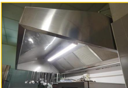
Cappa aspirafumi in acciaio sprovvista di motore.
