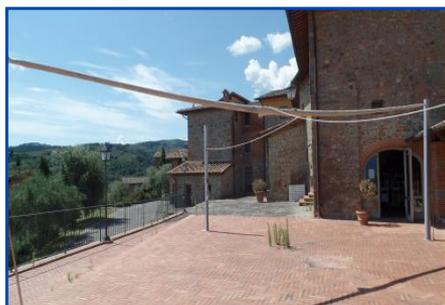
Struttura tenda quadrata con quattro montanti ancorati a terra e struttura tenda con due montanti ancorati a terra
