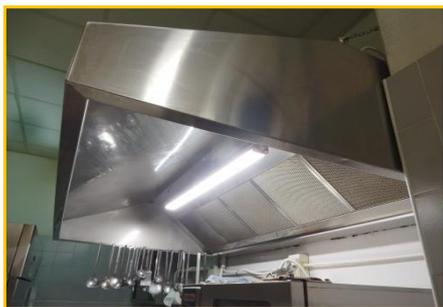
Cappa aspirafumi in acciaio sprovvista di motore.
