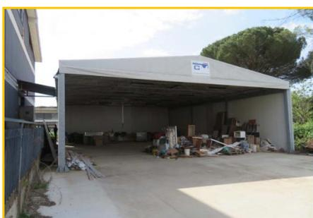
Struttura esterna marca CM Chiusure ancorata a terra con telone scorrevole nella parte superiore e pannelli laterali, completa di impianto luci, dimensioni circa metri 13 x 10.
