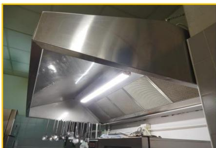
Cappa aspirafumi in acciaio sprovvista di motore.
